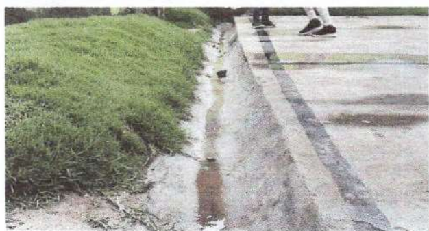
Foto 1: En la foto se puede observar la reparación de la cuneta.
