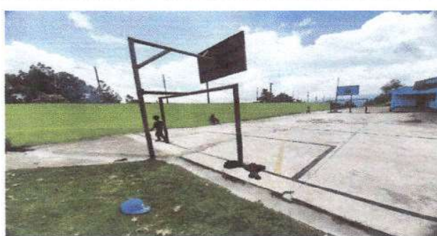
Foto 4: Se observa otras partes de la reparación de la cuneta.
