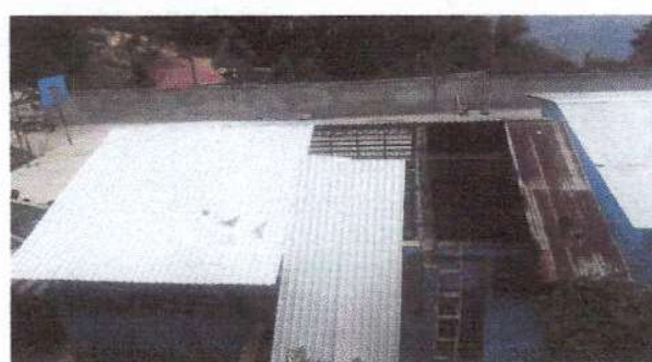
Foto 2: Se observa el aula del módulo No.2. la sustitución de lámina.
