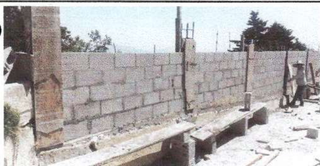
Foto 5: En la foto se observa la reparación del muro perimetral.
